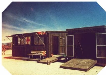
POSTE DE SECOURS 100% PIN MARITIME ET DÉPLAÇABLE - BISCARROSSE -
